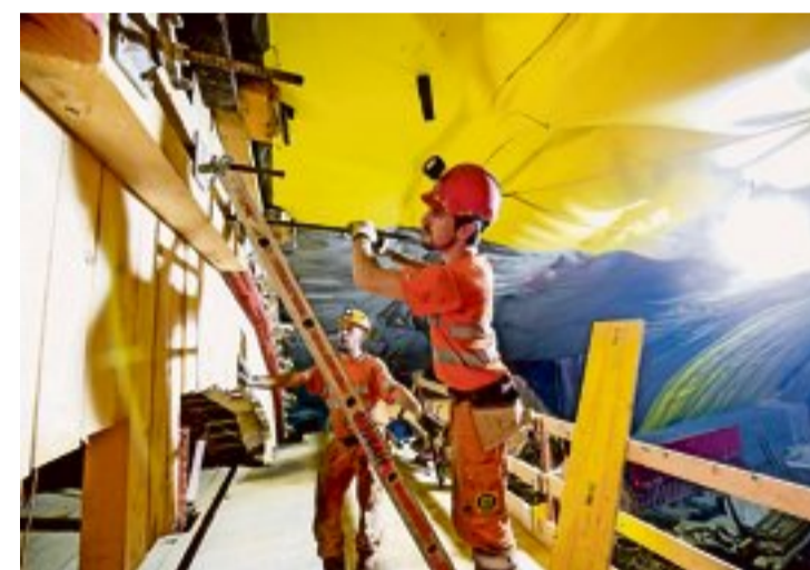
Bauarbeiter auf dem Schalungsgerüst in Aktion.
