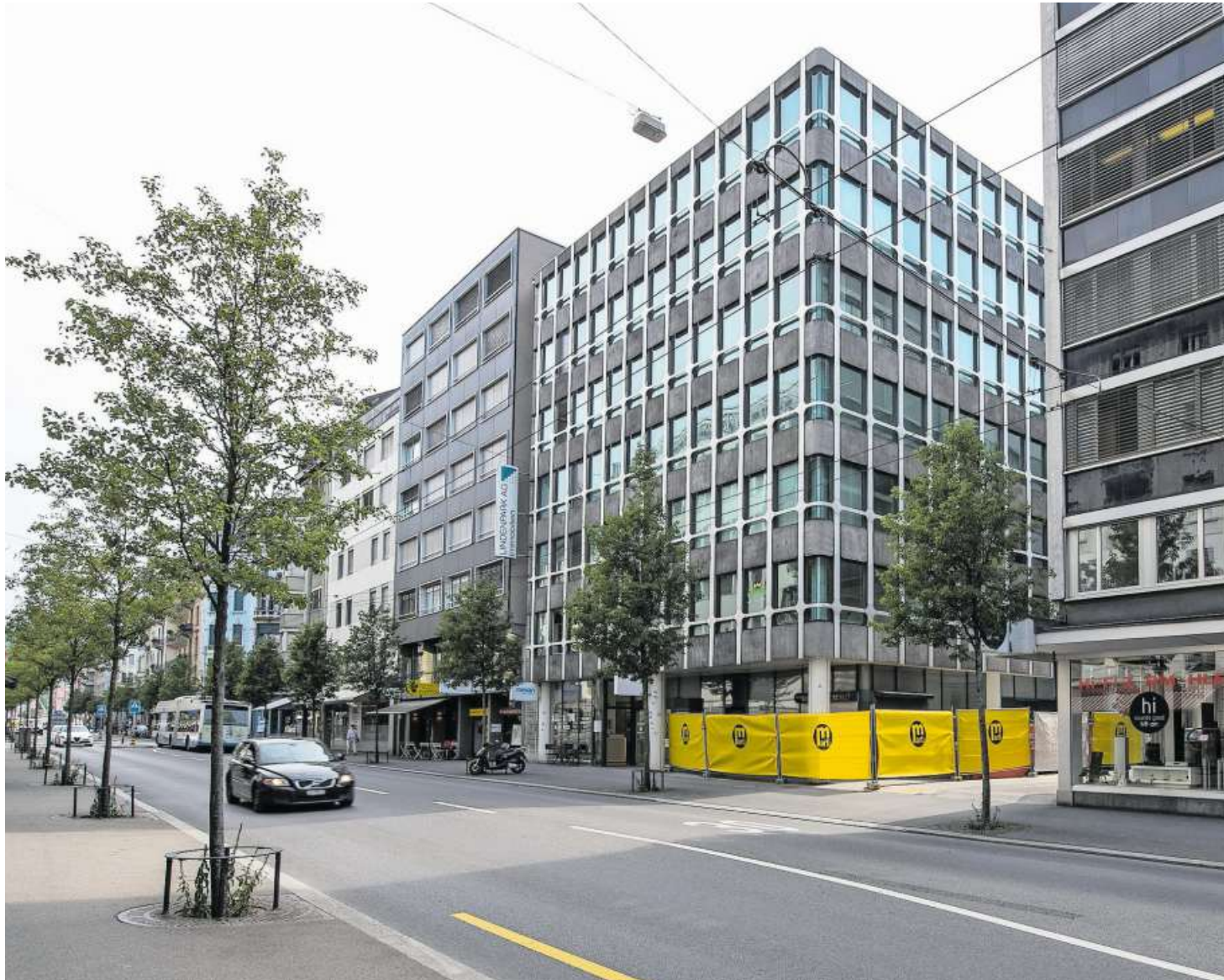
Das Haus an der Hirschmattstrasse 36 ist ein Vertreter der architektonischen Moderne.
