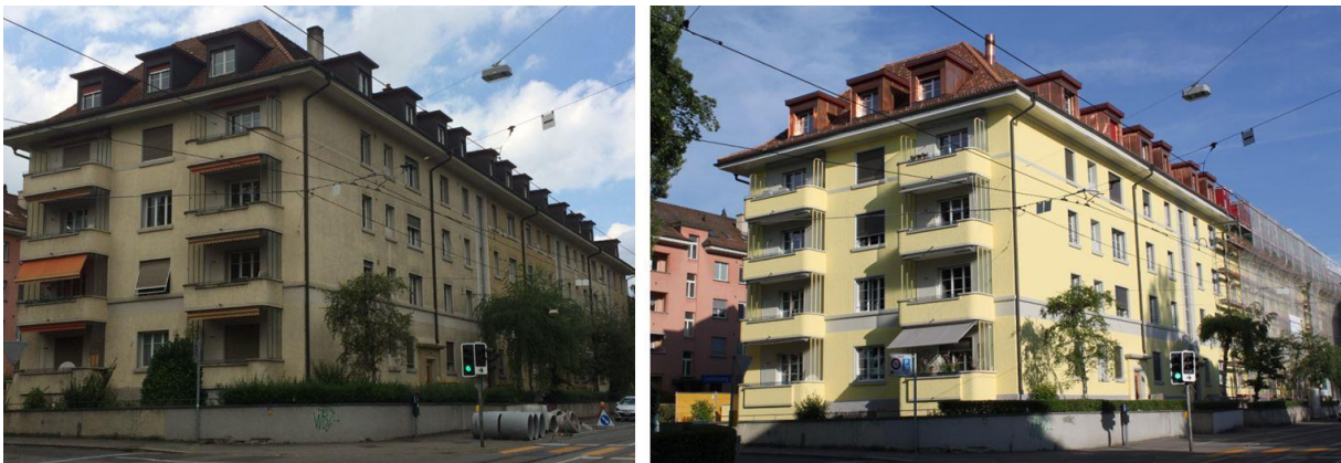
Links: Gebäudehülle vor Sanierung; rechts: Gebäudehülle nach Sanierung
