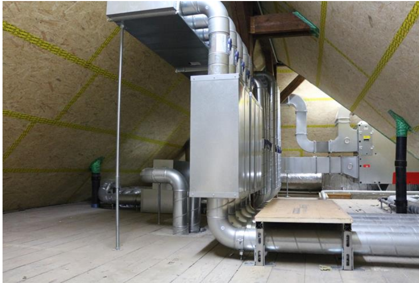
Lüftungsinstallation im Estrich
