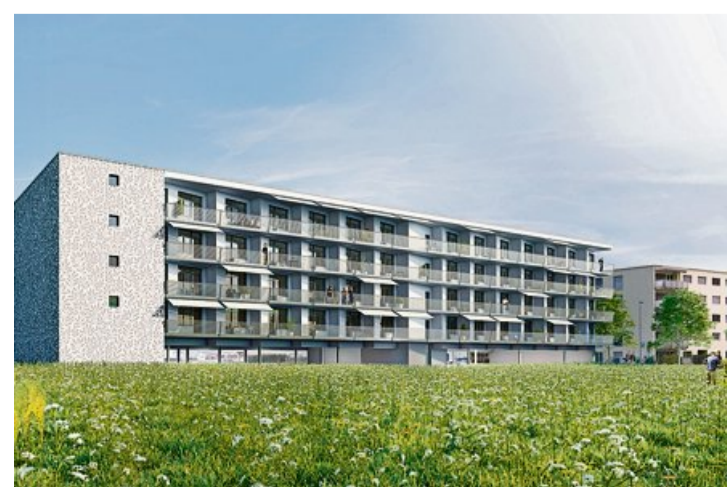
Das viergeschossige Personalhaus steht auf Stützen, was die Durchsicht auf dem Niveau des Erdgeschosses ermöglicht.
