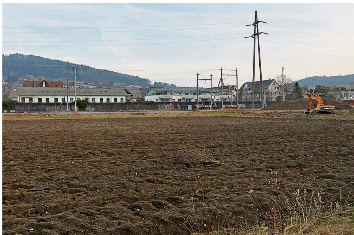
Das Grundstück für die geplanten Personalwohnungen befindet sich zwischen der Firma Hiag (links, nicht im Bild), den Bahngleisen und dem Seniorenzentrum Senevita, für das die Bauarbeiten (rechts) bereits begonnen haben.
